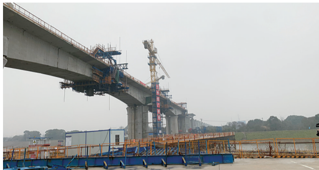
项目施工现场
