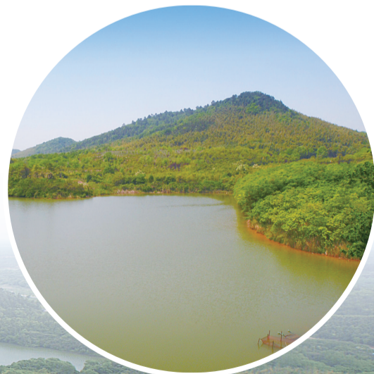
花园坝水库一角
