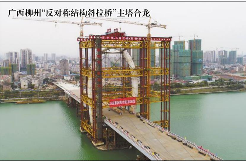
日前，由中铁上海局承建的目前世界上最高、跨度最大的“反对称结构斜拉桥”——广西柳州白沙大桥主塔成功合龙，标志着大桥建设正式进入最后阶段。白沙大桥的主塔最高点达106米，为空间异形结构，仿佛将两根笔直的钢塔在空中拧成一个“麻花”。图为建设中的广西柳州白沙大桥。
