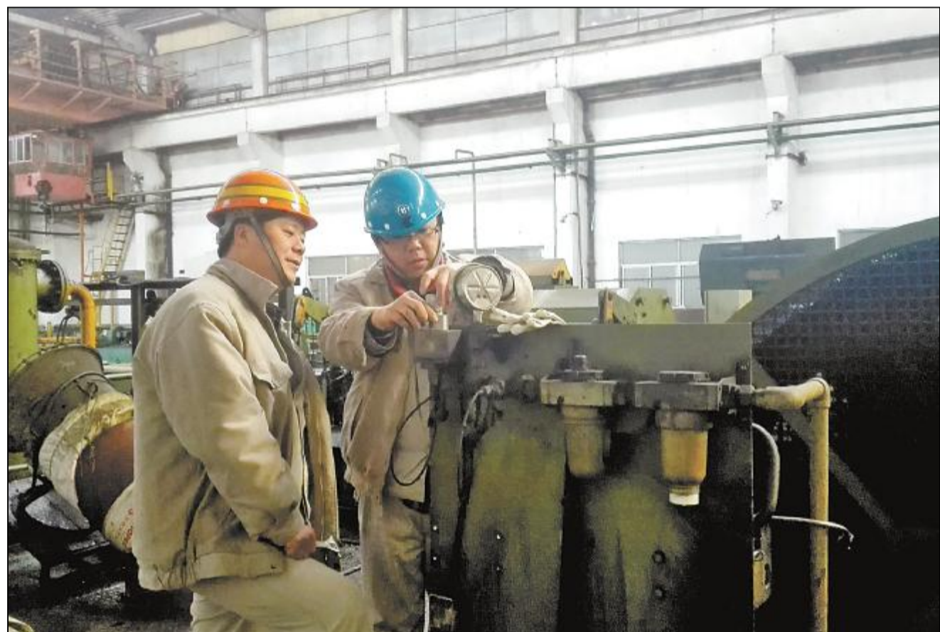
日前，宝钢特钢钢管厂东区设备维护团队，协同配合、快速处置，通过对已有电磁网的改进来替代原进口产品，顺利解决了KPW-50高速冷轧机主离合器故障，确保了生产正常进行。
