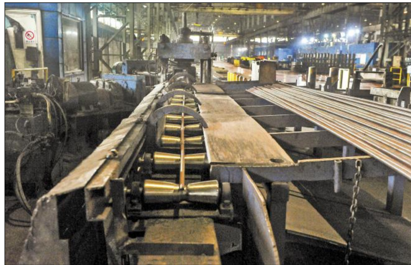
近日,宝钢特钢钢管厂广东区设备维护团队,协同配合、群策群力、快速处置,通过对已有电磁阀的改进来替代原进口产品,顺利解决了KPW-50高速冷扎机主离合器故障,确保了生产顺利进行。图为设备维护人员在现场调试。
