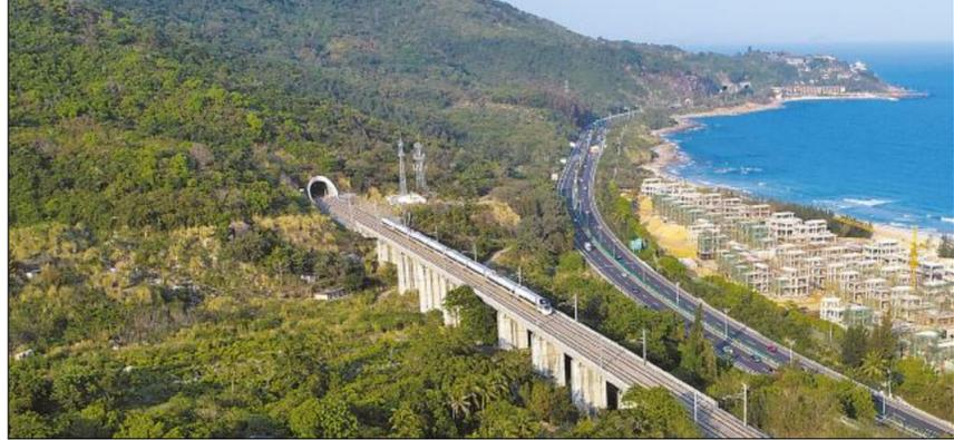
世界首条环岛高铁——海南环岛高铁以旅游轴线为骨架,将海南几乎所有著名景点和重要城市串联起来,全长653千米,于2015年12月30日实现全线贯通,去年旅客发送总量突破2500万人次。海南环岛高铁在防海水倒灌侵蚀、防高温高湿、防风防腐防盐害、防雷防震等方面实现了技术攻关,为我国积累热带高铁建设、运营提供宝贵经验,也为海南建成世界一流的海岛休闲度假旅游胜地提供有力支撑。图为在环岛高铁东段陵水站附近,列车从海边驶过。
