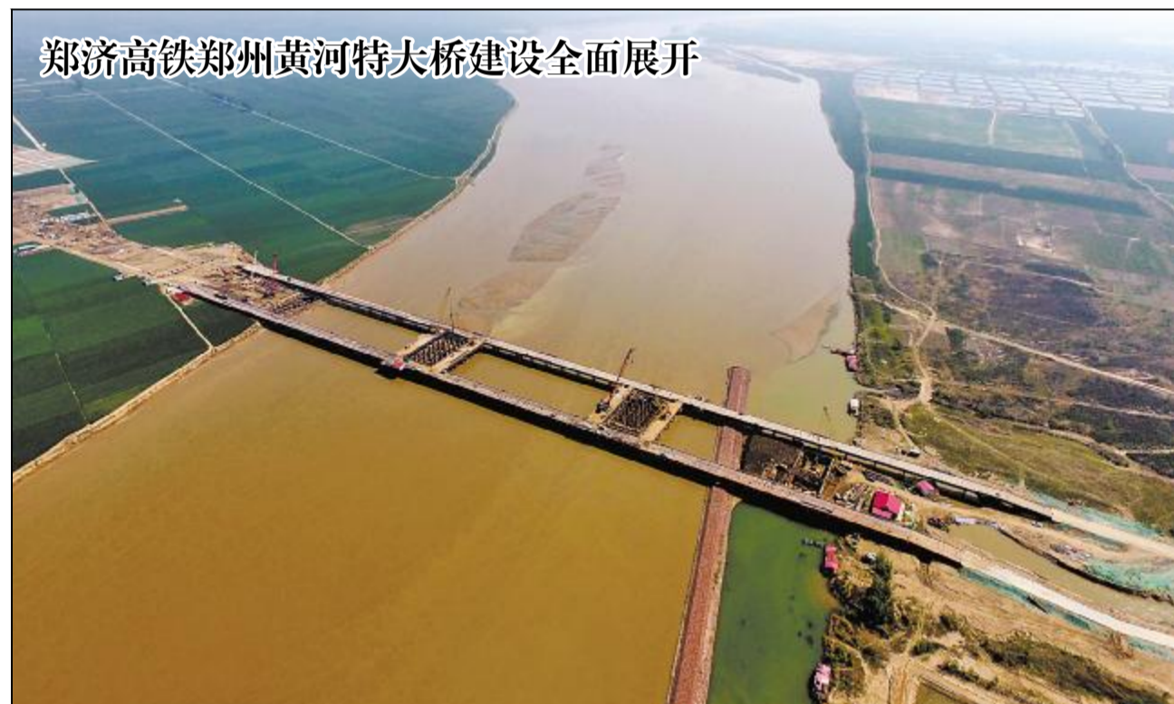
目前, 由中铁大桥局承建的郑(州)济(南)高速铁路郑州黄河特大桥建设工程进入全面施工阶段。郑济高速铁路郑州黄河特大桥主桥及南引桥全长4377米, 采用公路、铁路上下层合建的形式, 设计4线铁路、6车道快速路, 预计2020年4月完工。图为施工中的郑济高铁郑州黄河特大桥。 新华社 供稿
