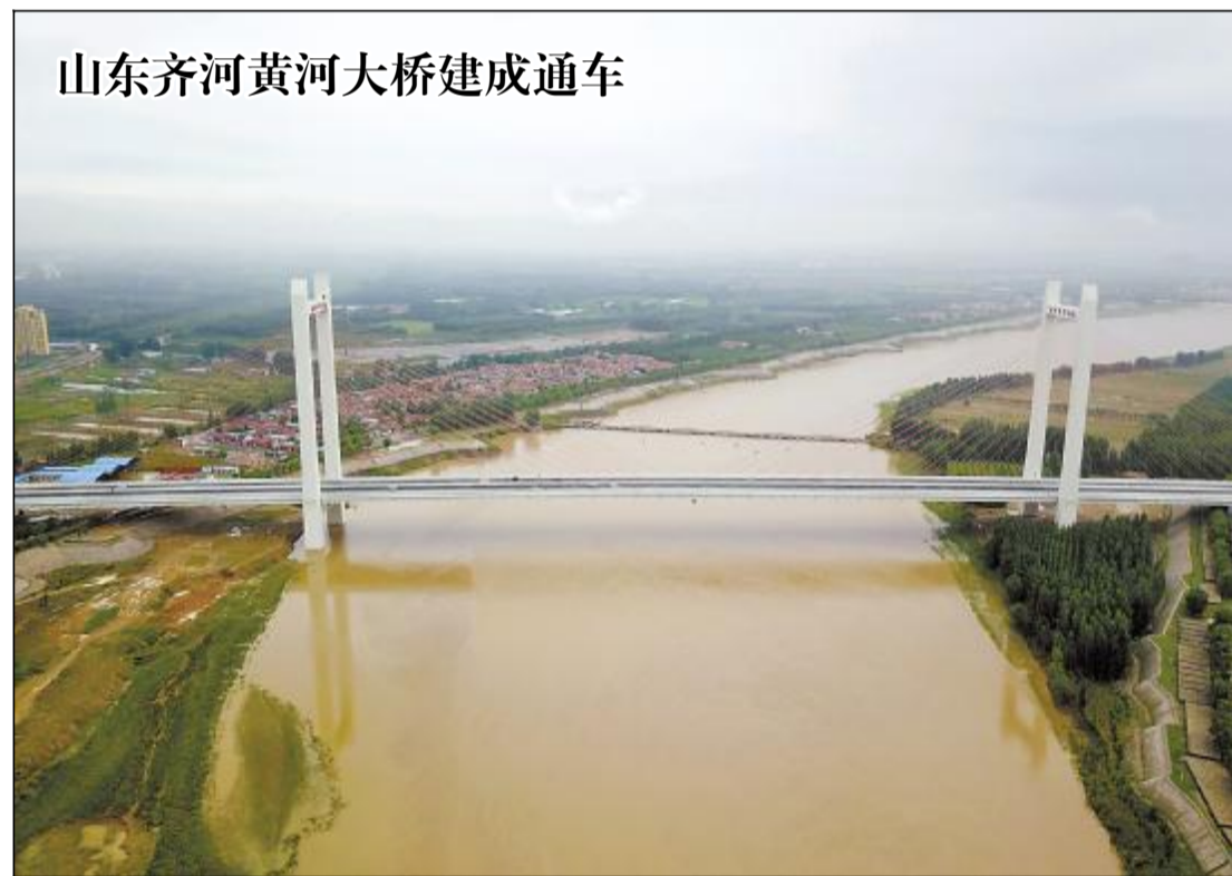
日前，山东齐河黄河大桥正式通车。大桥全长三千七百六十七点九米，主桥八百四十米，桥宽三十五米，采用双向六车道一级公路标准，并预留轨道交通通道。大桥的建成通车将有力改善齐河西部与德州、聊城市及周边的交通出行条件。
