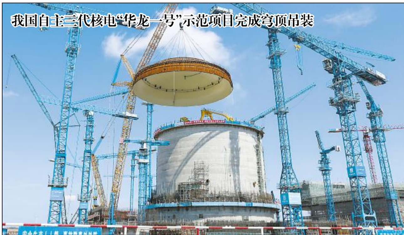
我国自主三代核电“华龙一号”示范项目完成穹顶吊装
