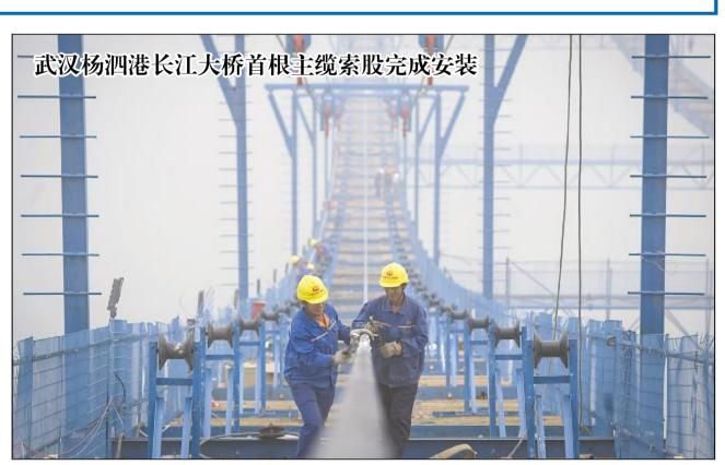
日前,武汉杨泗港长江大桥首根主缆索股安装完成,标志着这座世界最大跨度双层悬索桥建设正式进入主缆架设阶段。 武汉杨泗港长江大桥为双塔双层地锚式钢桁梁公路悬索桥,主跨1700米,是武汉市第10座长江大桥,也是长江上首座双 层公路大桥,由中铁大桥局施工建设。
