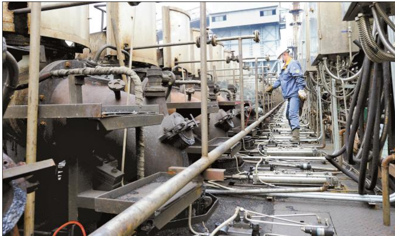
宝钢股份宝山基地炼铁厂三期焦炉上升管，由于服役时间较长，结构腐蚀严重造成操作时排放异常。为提升生产水平和满足环保要求，炼铁厂于前年启动了上升管节能环保改造项目。项目为期两年，将更换200套上升管底座及内衬和配套自动执行机构等。改造完成后的焦炉炉顶排放物将达到国标最高水准。目前，项目正紧张施工中。图为改造施工现场。
