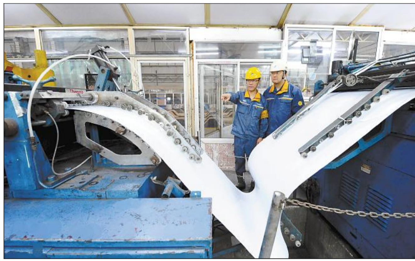
日前,宝钢股份镀锌板厂对投产20余年剪切机组集中力量进行现场攻关。改善小组经过反复实验,总结出一套提高剪切精度的操作流程,不但降低了划伤缺陷而且提高了生产效率和产品质量,以较小的投入让高压机组焕发“青春”。图为技术管理人员和现场操作人员正在交流剪切线活套辊的维护措施。 记者 张勇 摄影报道
