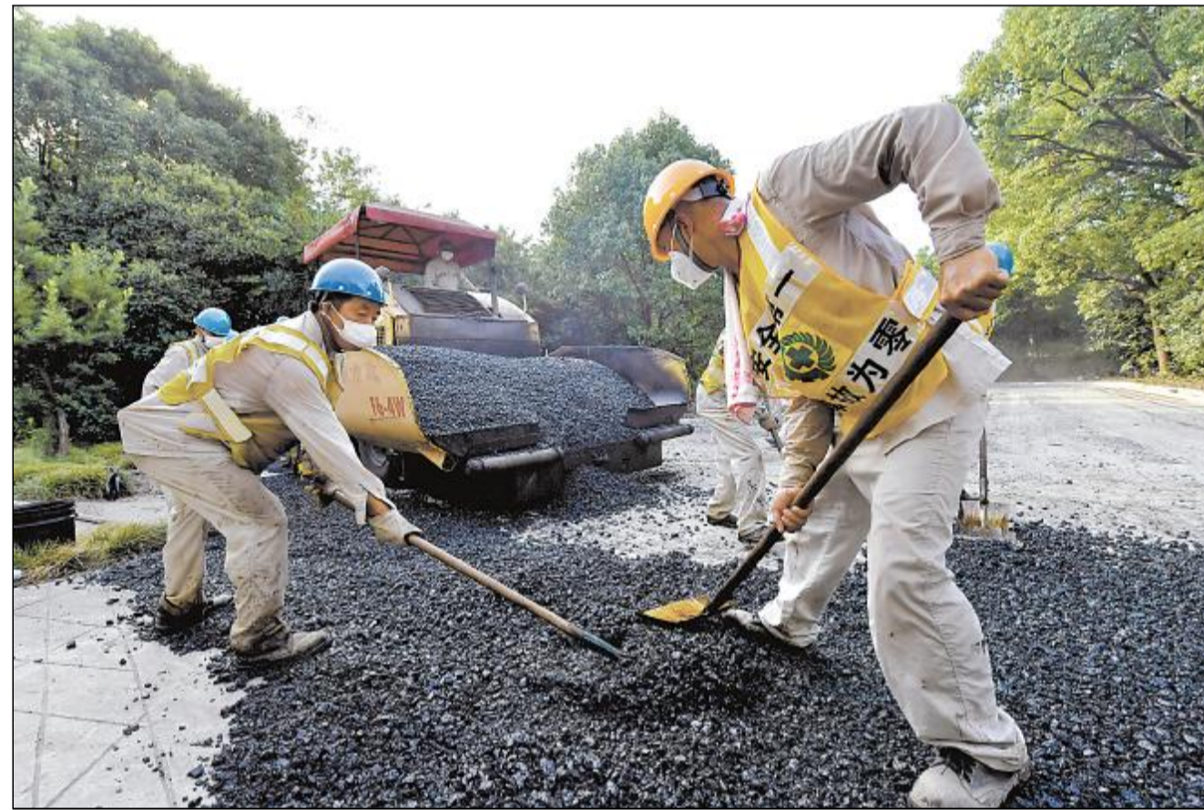
日前,宝钢股份指挥中心停车场周边道路改造项目的沥青铺设工作已进入收尾阶段。虽是早上七点,一百多摄氏度的沥青早已把周围烤得像蒸笼。上海源康物业市政工程部员工经受着酷暑高温“烤”验,用一滴汗水为我们的顺利出行做好保障。
