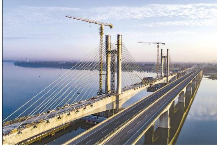
日前,由中铁十一局集团承建的豪华铁路汉江特大桥位于湖北省襄阳市区上游约三千米的汉江上,总长五千二百四十二米,是豪华铁路重点控制性工程之一。该桥江面共十八座桥墩,位于江面上的主桥为双塔五跨部分斜拉桥,最大跨径二百四十八米。 新华社 供稿
