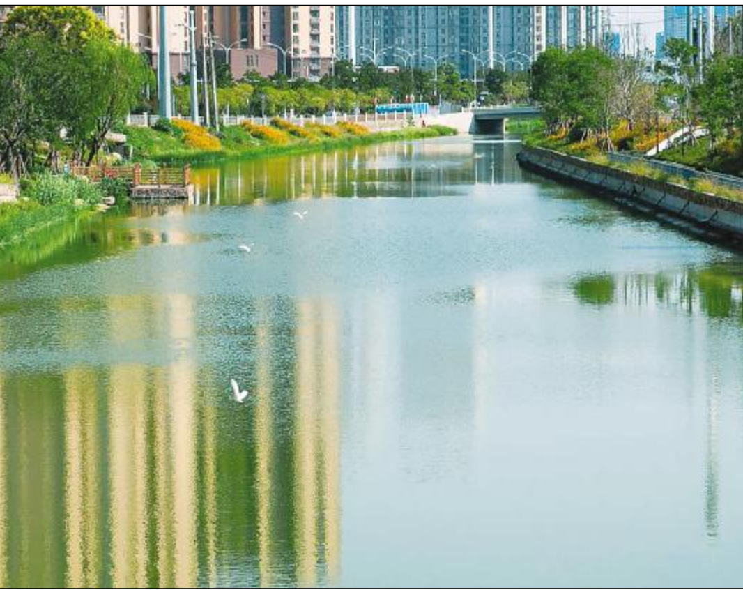
日前武钢集团绿色城建公司承建的武汉市青山港及二号码头整治、驳岸生态修复工程已全面完工。目前，明渠已连通外至长江，内至东湖沙湖及湖周边主要湖泊，形成了大湖水能排出、大草水可引入的区域生态内河流动互通通地群。用修、蓄、净、用、排(海绵)施工技术等落实标准。图为整治后的二号码头新景。 特约记者 朱旺春 摄影报道
