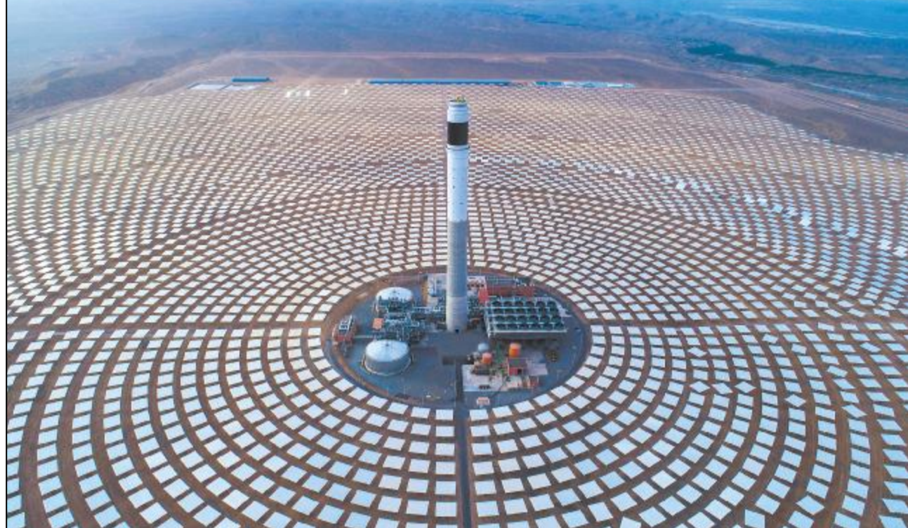
从2015年起,中国电建集团下属的山东电建三公司在瓦尔扎扎特承建努奥光伏电站二期和三期工程。努奥光伏电站项目是目前全球规模最大的光伏电站项目,二期工程槽式光伏电站现已进入商业运行,三期塔式光伏电站也于近日顺利实现首次并网目标。待项目完全建成后,努奥光伏电站将为超过100万的摩洛哥家庭提供清洁能源,还可以把富余的电出口到欧洲。图为摩洛哥瓦尔扎扎特的努奥光伏电站三期工程(航拍照片)。
