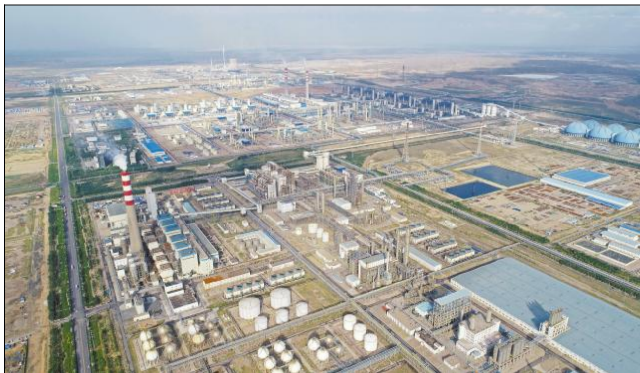
从挖煤到输电,从卖炭到卖油,从黑色煤炭到白色烯烃……因“煤”而兴的宁夏宁东能源化工基地在创新驱动战略下加速蝶变,一批“超级工程”拔地而起,进入快马加鞭高速增长阶段。15年来,宁东基地投资4800多亿元,年产值突破千亿元,成为西部地区乃至全国煤炭清洁高效利用的“领跑者”。
