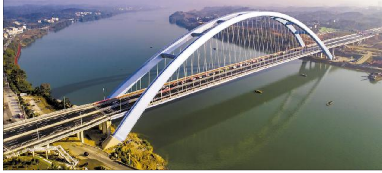
日前,广西柳州市官塘大桥正式建成通车。大桥横跨柳江,水中不设桥墩,跨径达到457米,整桥主线全长1155.5米,桥面由148根吊索与上方的两条拱座相连,是世界最大跨度有推力钢箱拱桥。该桥梁造价11.7亿元,设计时速每小时80千米。图为参加通车仪式的车辆通过广西柳州官塘大桥。 新华社 供稿
