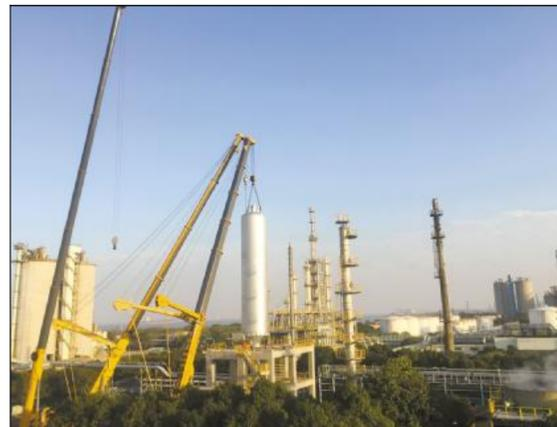
日前,由中冶宝钢技术第二分公司承建的宝武炭材新型炭材料升级改造项目建设安装工程完成相塔设备吊装。新型炭材料升级改造工程完成后主要产品为针状焦,设计年产能5万吨,并将形成3大系列的碳素产品。
