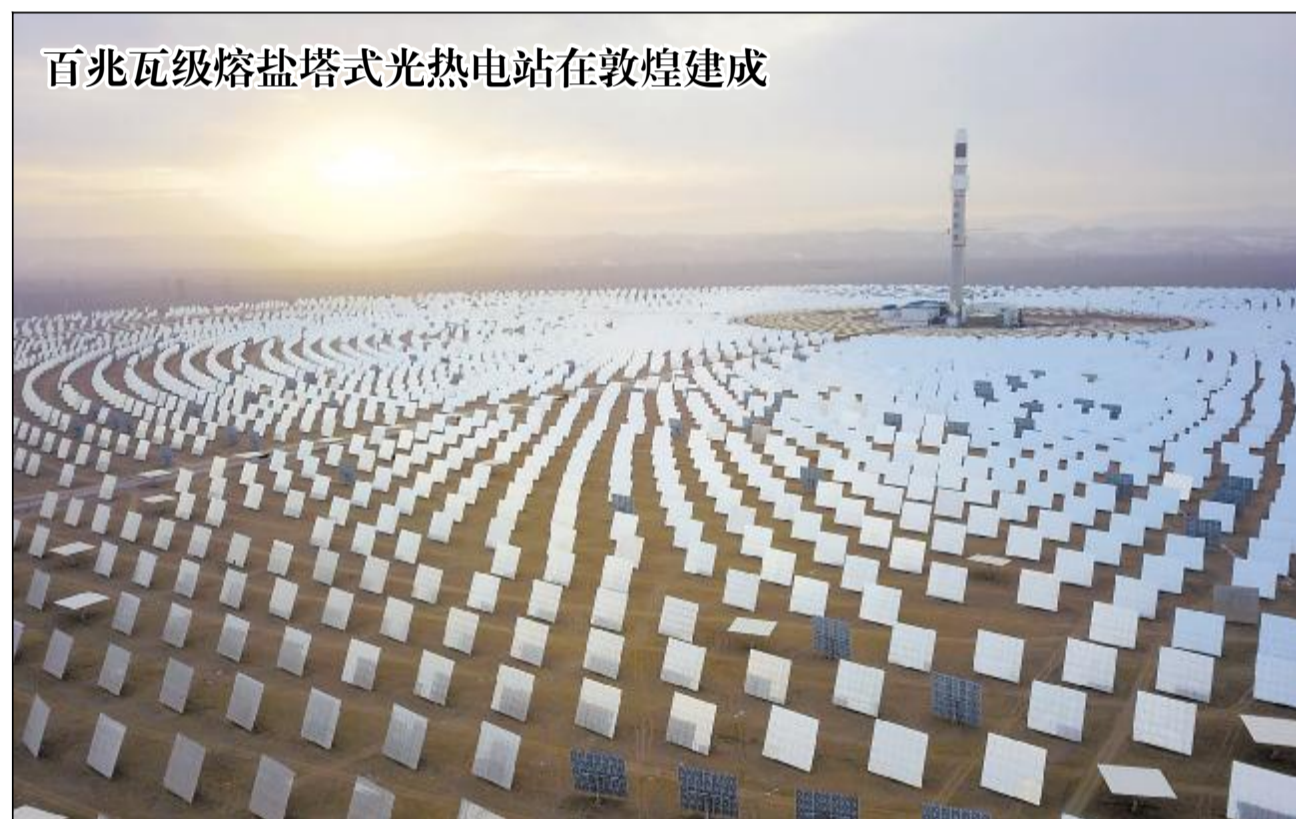
日前,百兆瓦级光伏电站——首航节能敦煌100兆瓦熔盐塔式光伏电站在甘肃省敦煌市建成,并完成各项调试工作,具备发电能力,即将并网投运。这是我国现阶段建成规模最大、吸热塔最高、可24小时连续发电的100兆瓦级熔盐塔式光伏电站。图为在敦煌市光电产业园区拍摄的敦煌100兆瓦熔盐塔式光伏电站局部。
