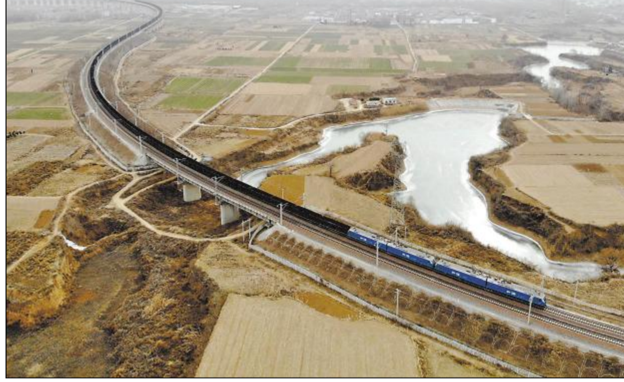
去年全年,瓦日铁路共开行万吨重载列车7000余列。瓦日铁路西起山西省吕梁市兴县瓦塘镇,东至山东省日照市日照港,是一条按30吨重载铁路标准建设的铁路,也是我国“西煤东运”的一条重要能源通道。图为—列重载列车行驶在瓦日铁路红旗渠至水冶南段。
