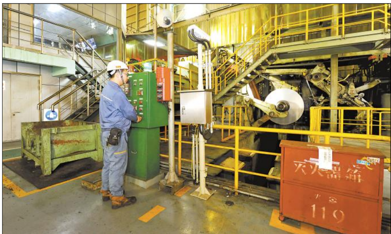
宝钢股份宝山基地冷轧厂积极应对成本变革压力，从变动工成本入手，加强精益化操作管理，取得显著成效，一月份变动成本完成率2189%，出色完成了公司下达的成本削减任务。图为冷轧厂C512机组生产现场。 记者 张勇 通讯员 王冠鹏 摄影报道
