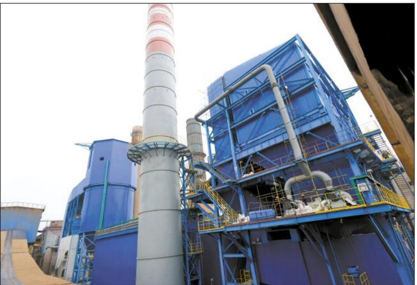
4月21日,经过一个月的热负荷试车和调试,鄂城钢铁2号260平方米烧结烟气脱硫脱硝改造项目正式投入运行,所有出口排放数据均达到超低排放标准,运行效果显著,完全满足大气污染防治超低排放限值要求。项目的投产也为鄂钢打赢蓝天碧水净土保卫战,打造极致高效安全智慧钢厂,助力高质量钢铁生态圈建设添砖加瓦。
