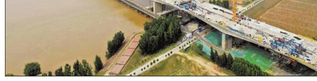
日前、国内首座将体外预应力技术应用于大规模连续梁的特大桥——官渡黄河特大桥主桥在河南郑州市中牟县的黄河之 上成功合龙。这标志着官渡黄河特大桥全线贯通,预计年内具备通车条件。据相关人士介绍,"如果把桥梁比喻成人体,钢筋就是 骨骼,混凝土就是肉身,体内预应力就是筋,体外预应力就好比搬运或行走助力器,减轻了桥体负担,检修方便,容易更换,从而
