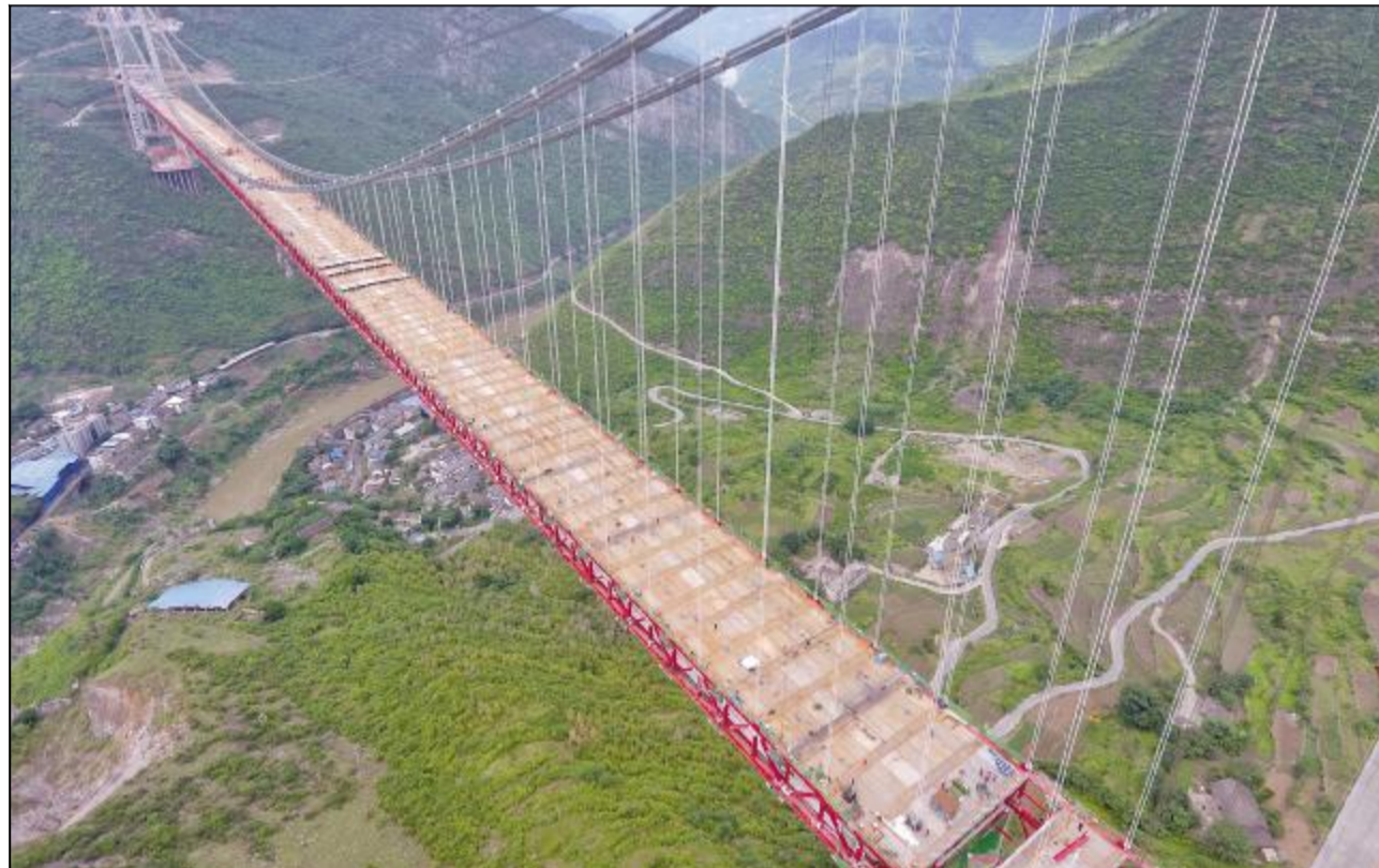
四川古蔺至贵州习水段高速公路赤水河大桥日前成功合龙，标志着该桥建设进入最后冲刺阶段，为今年9月底完成大桥主体工程奠定了坚实基础。
