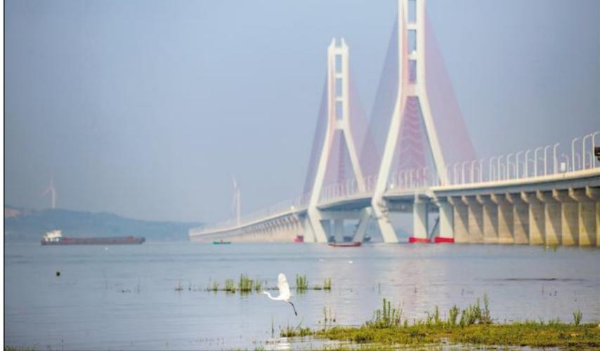
日前，江西鄱阳湖二桥正式通车，标志着环鄱阳湖地区的又一重要交通控制性工程正式投入使用。据介绍，鄱阳湖二桥全长5.589千米，起自江西都昌县多宝乡，终于庐山市华林镇。桥梁采用主跨达420米的双塔斜拉桥，尽可能减小桥墩物理障碍对鱼类迁移的影响。这也是中国第一大淡水湖鄱阳湖上建成的第二座大桥。
