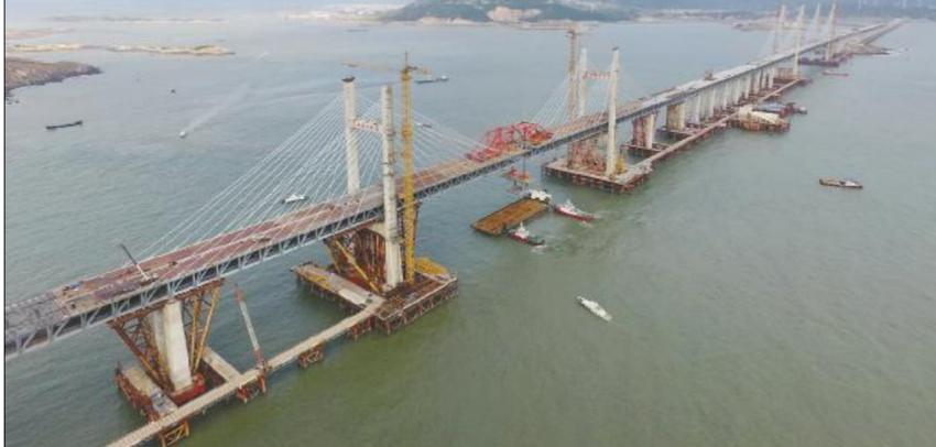
日前，平潭海峡公铁两用大桥塔门航道的桥墩合龙，标志着世界在建难度最大、最长跨海公铁两用大桥全桥贯通，大桥预计在明年全面通车。大桥所处的台湾海峡，是世界上著名的三大风暴海域之一。这片海域环境复杂，风大、浪高、流急、石硬，波浪力是长江等内河的10倍以上，全年6级以上大风超过300天。
