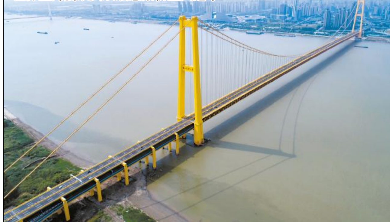
日前，长江上首座双层公路大桥——武汉杨泗港长江大桥正式投入使用。杨泗港长江大桥全长4.13千米，主跨1700米，该桥采用双层公路悬索桥结构，上下两层均按照双向6车道布置，是长江上第一座双层公路大桥。桥梁两侧还设有非机动车道及人行观光道，是世界上通行能力最大、使用功能最完备的大跨悬索桥。图为武汉杨泗港长江大桥正式通车(无人机拍摄)。
