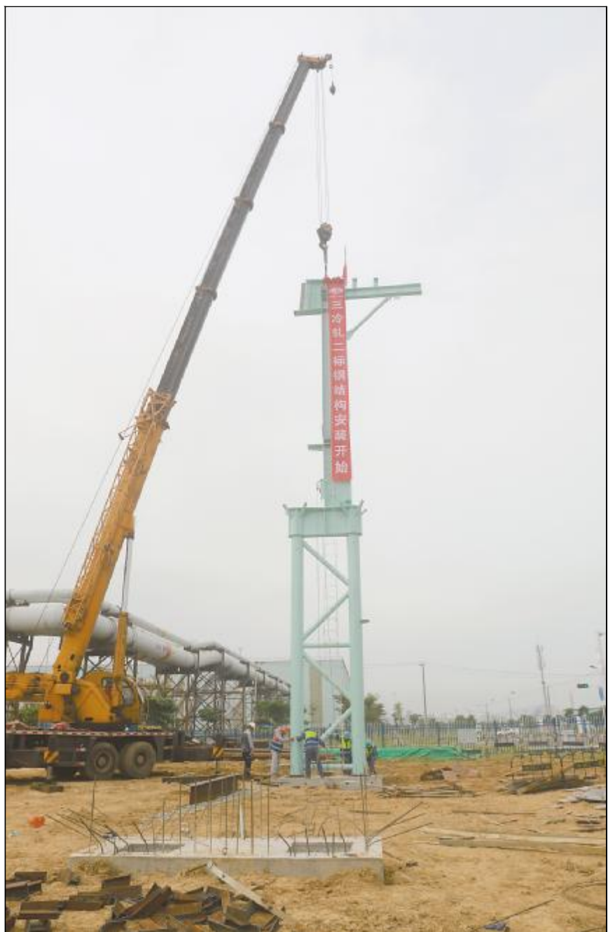
日前，湛江钢铁三冷轧二标主厂房结构首柱顺利吊装就位，标志着由宝钢工程承接的湛江钢铁三高炉系统冷轧工程进入主厂房钢结构安装阶段。
