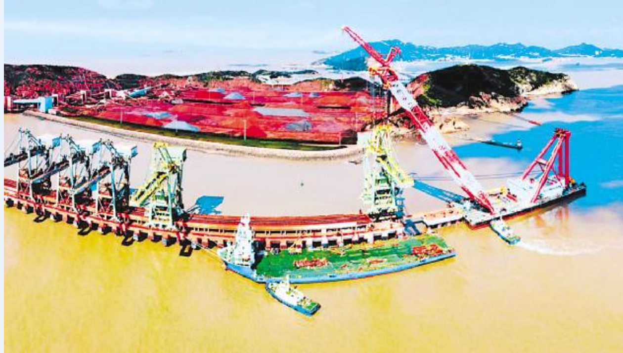
日前,宝钢股份运输部马迹山港两台自重为1950吨/台的抓斗式卸船机一次吊装成功,创造了国内典型外海开敞式深水港口超大型港机设备整机吊装的纪录。两台新卸船机的卸船能力均为2500吨/小时,大大提升了马迹山港卸船作业能力。图为马迹山港码头吊装现场。
