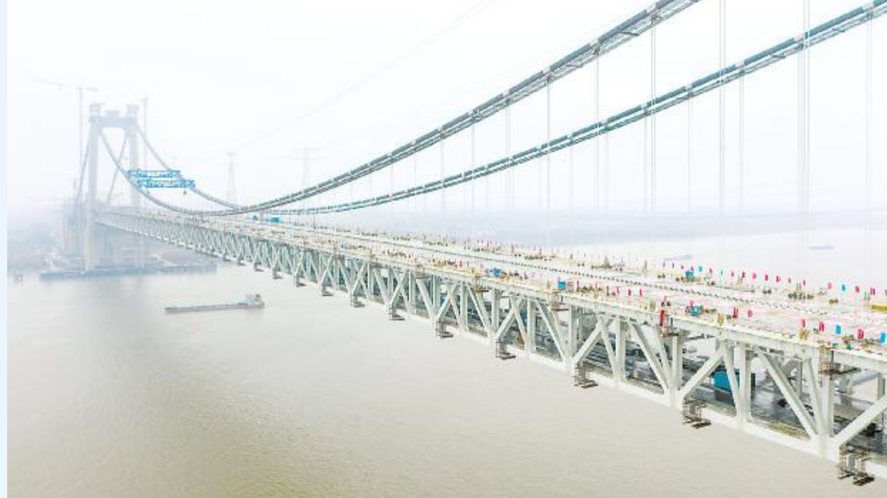
日前，我国首座公铁两用悬索桥五峰山长江大桥完成最后两节钢梁焊接，成功实现主桥合龙，该桥是世界上首座千米级高铁悬索桥。五峰山长江大桥连接江苏扬州市与镇江市，是连云港—镇江高速铁路的过江通道。大桥全长6409米，主跨1092米，上层为双向八车道高速公路，设计时速为100千米。下层为四线高速铁路，设计时速为250千米。图为成功合龙的公铁两用悬索桥五峰山长江大桥。
