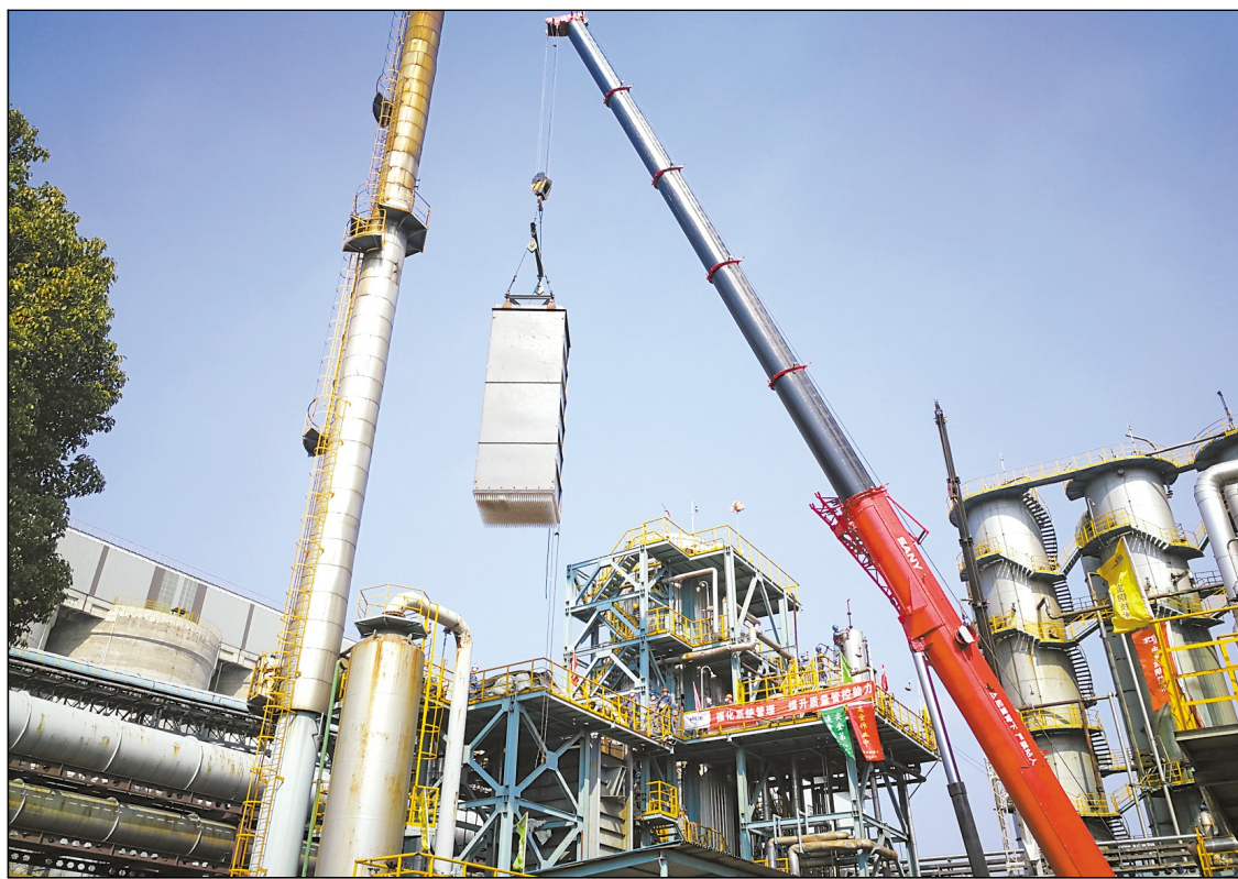
日前,梅钢精整脱硫酸装置更新成功,系统运行稳定,比计划提前一天恢复生产。陈兴梅 庞雪峰 摄影报道
