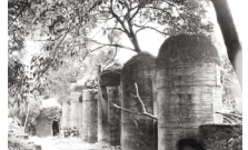
▲“大办钢铁”时期由当地村民兴建的上高炉,建成后实际并未使用。
