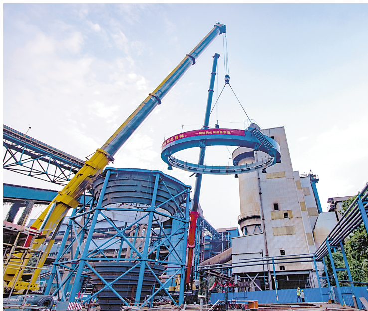
日前，由宝武重工钢结构公司负责安装的脱硫塔环梁，在马钢集团炼铁总厂正式吊装。该环梁直径20米，重53吨，是马钢集团炼铁总厂(南区)1号烧结机烟气脱硫脱硝及超低排放改造项目的核心部件。
