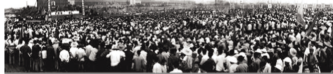
▲1974年9月，武钢一米七轧机工程开工誓师大会
