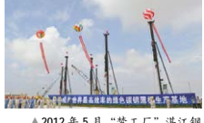
▲2012年5月，“梦工厂”湛江钢铁开工建设
