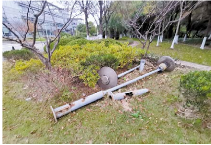
宝地吴淞西南侧路边，坏掉的路灯倒在绿化带里。
