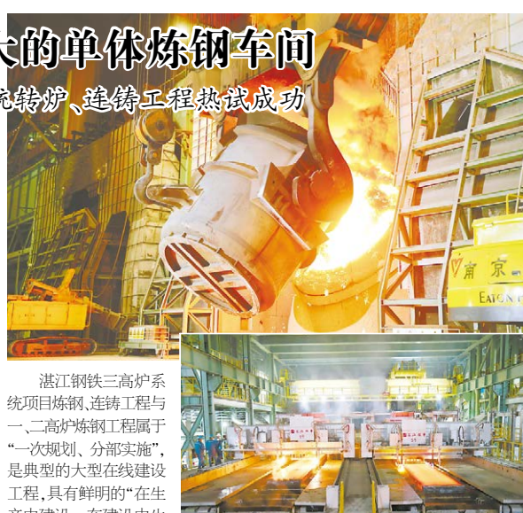
湛江钢铁三高炉系统项目炼钢、连铸工程与一、二高炉炼钢工程属于“一次规划、分步实施”,是典型的大型在建建设工程,具有鲜明的“在生产中建设、在建设生产中”特征,存在立体交叉项目多、工序协调要求高、能介新日接口复杂等增加建设施工难度的特点。
