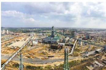
▲2015年7月，建设中的宝钢广东湛江钢铁基地高炉区域
