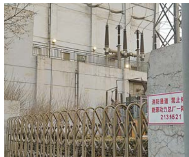
太钢能源动力总厂一降压站,厂房照明灯白天还亮着。
