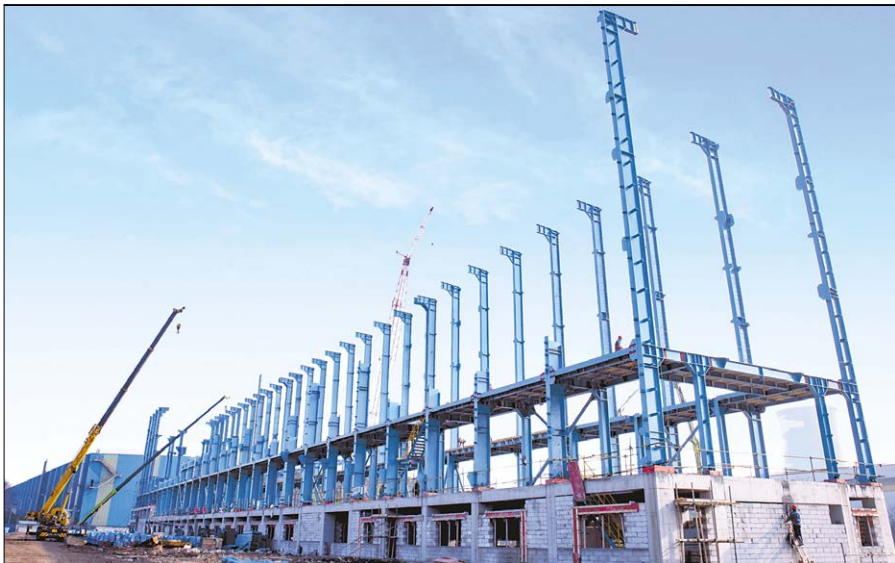
由宝武重工重工钢结构承担钢结构制作和安装的“马钢炼铁总厂（南区）带式焙烧工程”进入首个节点——焙烧室安装阶段（如图）。该项目是马钢集团“十四五”战略规划重点工程，钢结构制作与安装总量约 8000 吨，计划于今年 8 月底竣工。记者 张勇 通讯员 严珏 徐臻 摄影报道
