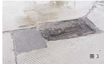
马钢股份厂区,11号门进门右拐处,雨水井盖下陷。
