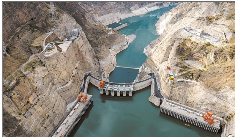
日前，世界第七、中国第四大水电站——乌东德水电站最后一台机组顺利完成72小时试运行，成功并入南方电网，正式投产发电。至此，乌东德水电站12台机组全部投产发电。
