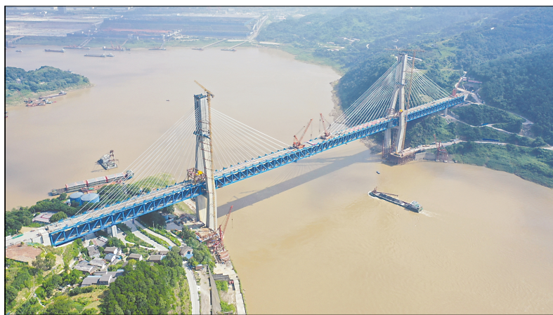
日前，重庆铁路枢纽东环线控制性工程——明月峡长江大桥顺利合龙。该大桥是国内首座双层四线铁路非对称花瓶型塔塔架斜拉桥，全长877.8米，其中主跨425米，上层为预留双线高速铁路，下层为重庆东环线客货共线双线铁路。图为明月峡长江大桥合龙施工现场。
