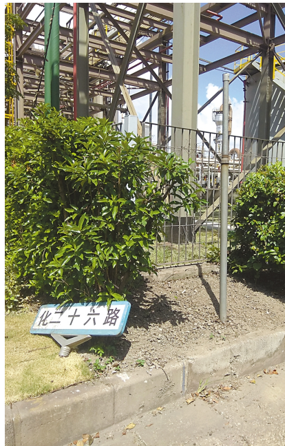
宝山化二十六路上路牌杆已折损，路牌丢弃在草坪上，日常维护缺失。
