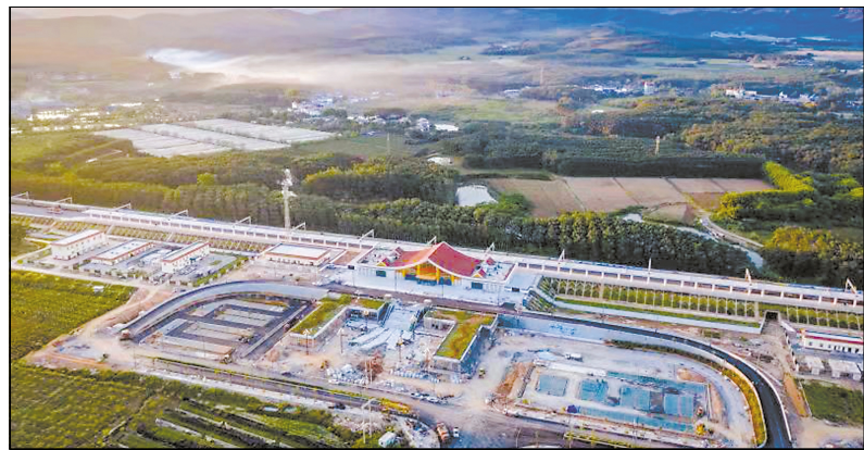
日前,中老铁路全线铺轨完成。中老铁路是一条连接中国云南省昆明市与老挝万象市的电气化铁路,由中国按中国铁路I级标准建设...
