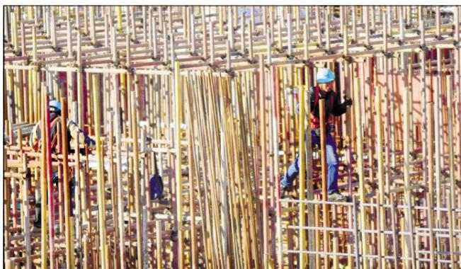
4300毫米中厚板生产线智能化升级改造是太钢重点推进项目。目前厂房柱基础工程全部完成，设备顶板支模、绑筋等作业正加紧进行，预计明年8月份建成投产。
