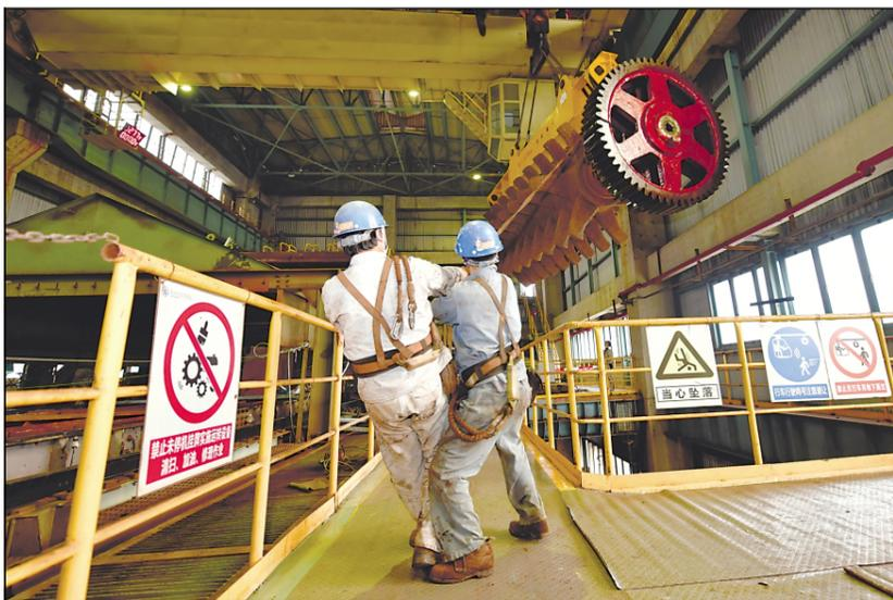
近日,宝钢股份宝山基地炼铁厂二号烧结机完成了自2018年11月投产以来的首次年修并顺利开机。本次年修历时15天,由宝钢股份宝山基地炼铁厂、设备部、中冶三分等部门协同完成。主要对烧结烟气内循环系统和活性炭烟气净化系统进行消缺优化,重点对二号机烟气净化功能和无组织排放进行技术改造,为烧结高效低耗生产以及创建A类绩效企业奠定了坚实基础。
