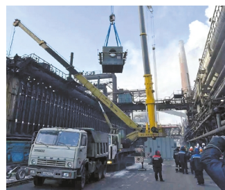
图为MMK项目施工现场。
