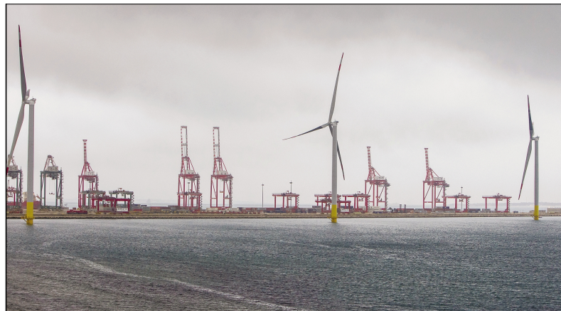
由中国公司提供关键设备的意大利贝莱奥利科海上风电项目日前在意大利南部港口塔兰托全容量并网。据介绍，这是意大利首个海上风电项目，总装机容量为30兆瓦，可以满足近两万个家庭的用电需求。图为在意大利南部港口塔兰托的贝莱奥利科海上风力发电机组。新华社 供图
