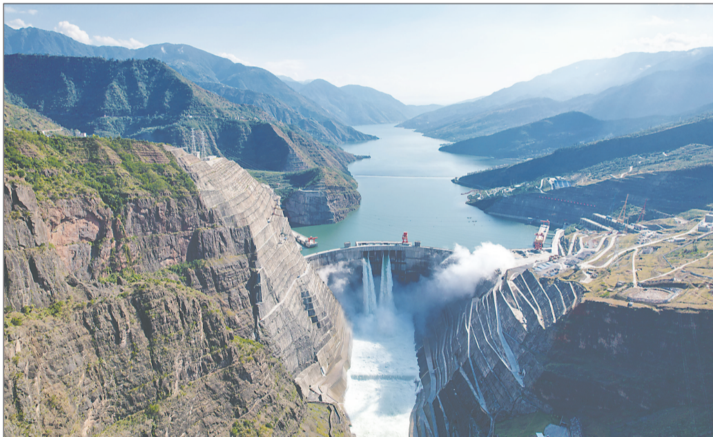
日前，白鹤滩水电站10号机组正式投入商业运行，这是白鹤滩水电站投产发电的第15台百万千瓦水轮发电机组，标志着白鹤滩水电站进入了全面投产发电的最后冲刺阶段。白鹤滩水电站位于四川省宁南县和云南省巧家县交界的金沙江干流河段上，总装机容量1600万千瓦，是我国实施“西电东送”的国家重大工程，共安装16台我国自主研发的全球单机容量最大功率百万千瓦水轮发电机组。新华社供图
